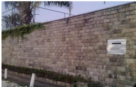
25. Alvenaria revestida com pedras (sem pontas).
