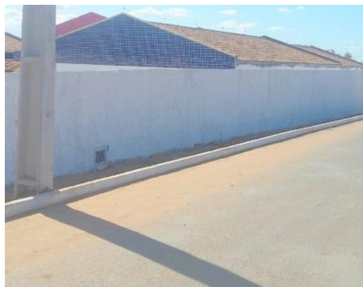
27. Alvenaria revestida com reboco ou emboço.
