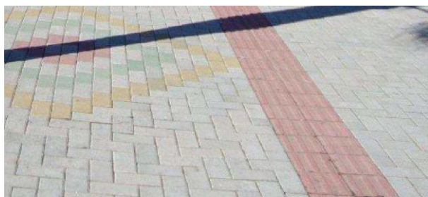
19. Passeio em bloco de concreto intertravado.
