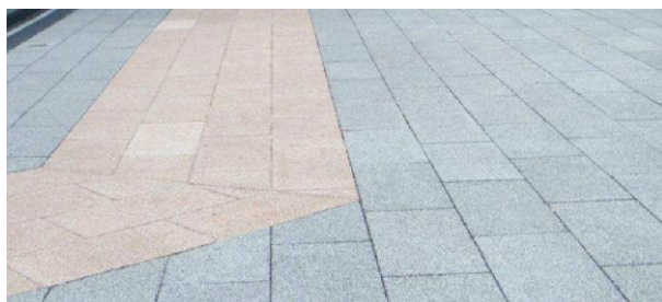
23. Passeio em placas de concreto drenante.
