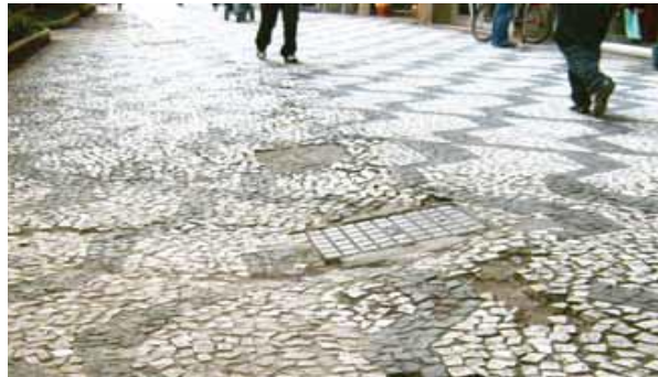
4. Material de piso inadequado e sem conservação.
