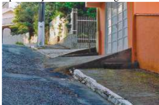
1. Degraus e inclinações transversais excessivas.
