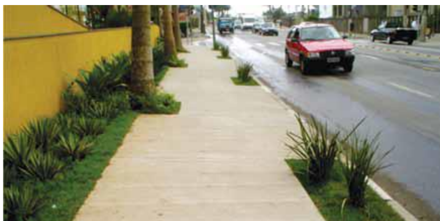
22. Passeio em concreto moldado in loco.
