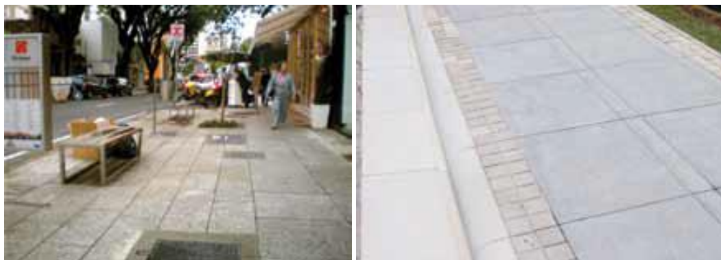
20. Passeio em placas pré-moldadas de concreto
