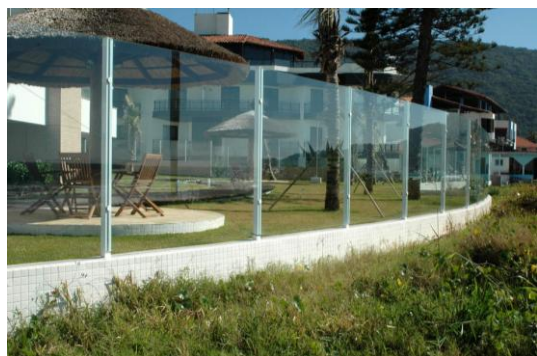
26. Fechamento em acrílico ou policarbonato.
