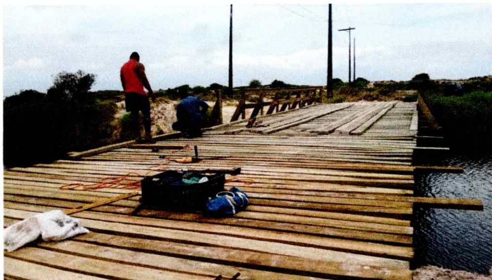
Assentamento do assoalho e defensas laterais para finalização.
