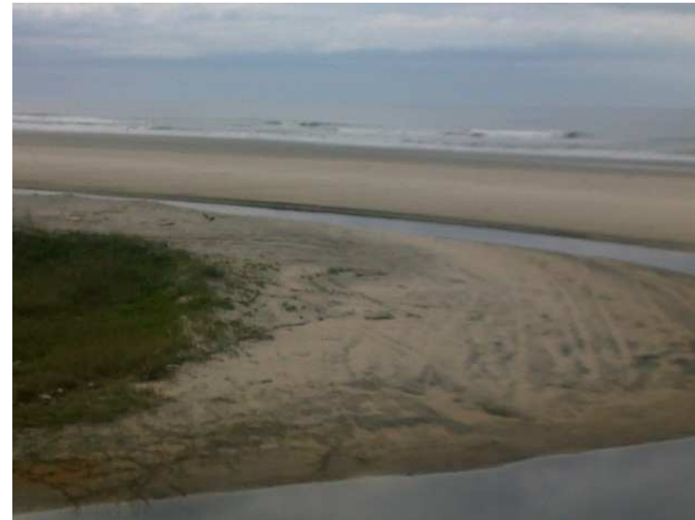
Figura 8 – Mudança de direção do escoamento por tentativa de reconstrução da praia
