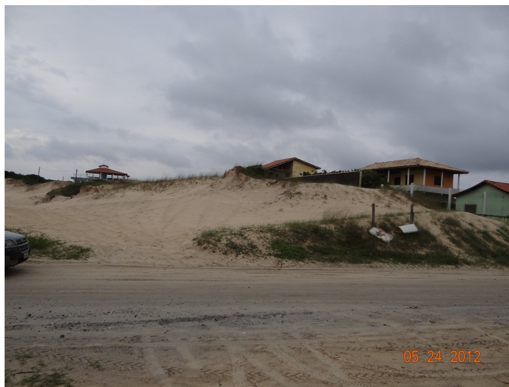
Foto 7: Casa construída sobre duna.
