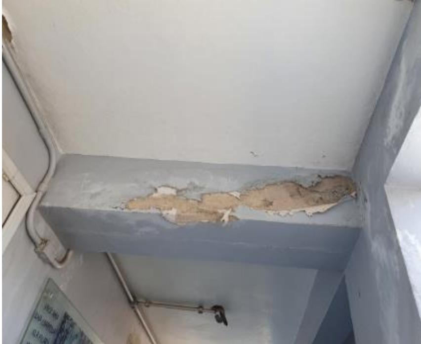
Foto 05: Infiltração e falta de acabamento
