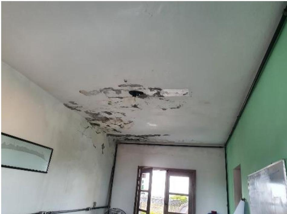
Foto 06: Plafon mal fixado com fios expostos, infiltração e trinca.
